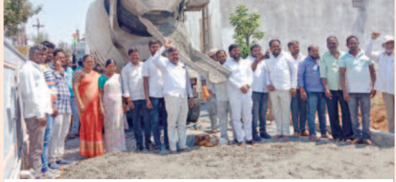
నందిగూడలోని ఎల్లమ్మ రాక్షలోని కాలనీలో సిమెంట్ రోడ్డు నిర్మాణ వసలను ప్రారంభిస్తున్న జడ్పివైస్ చైర్మన్ తదితరులు
